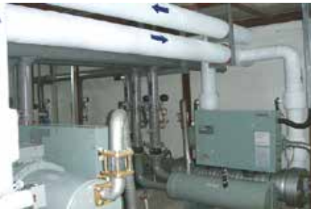
Alışlagelmiş Merkezi Su Kaynağı Ünite için Makine Dairesi
